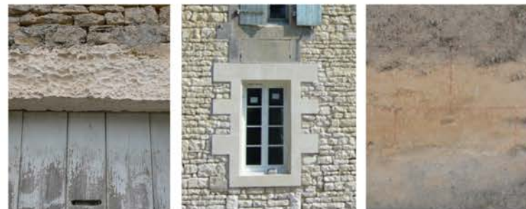
Linteau salpêtré - Restauration d'un encadrement de fenêtre - Joints en trompe-l'oeil sur un enduit ancien.
