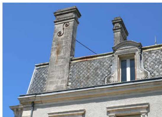
Toiture en ardoise
