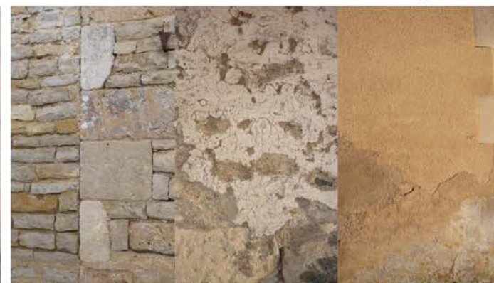
Détail de maçonnerie
