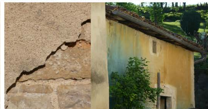
Maçonnerie jointée puis enduite
